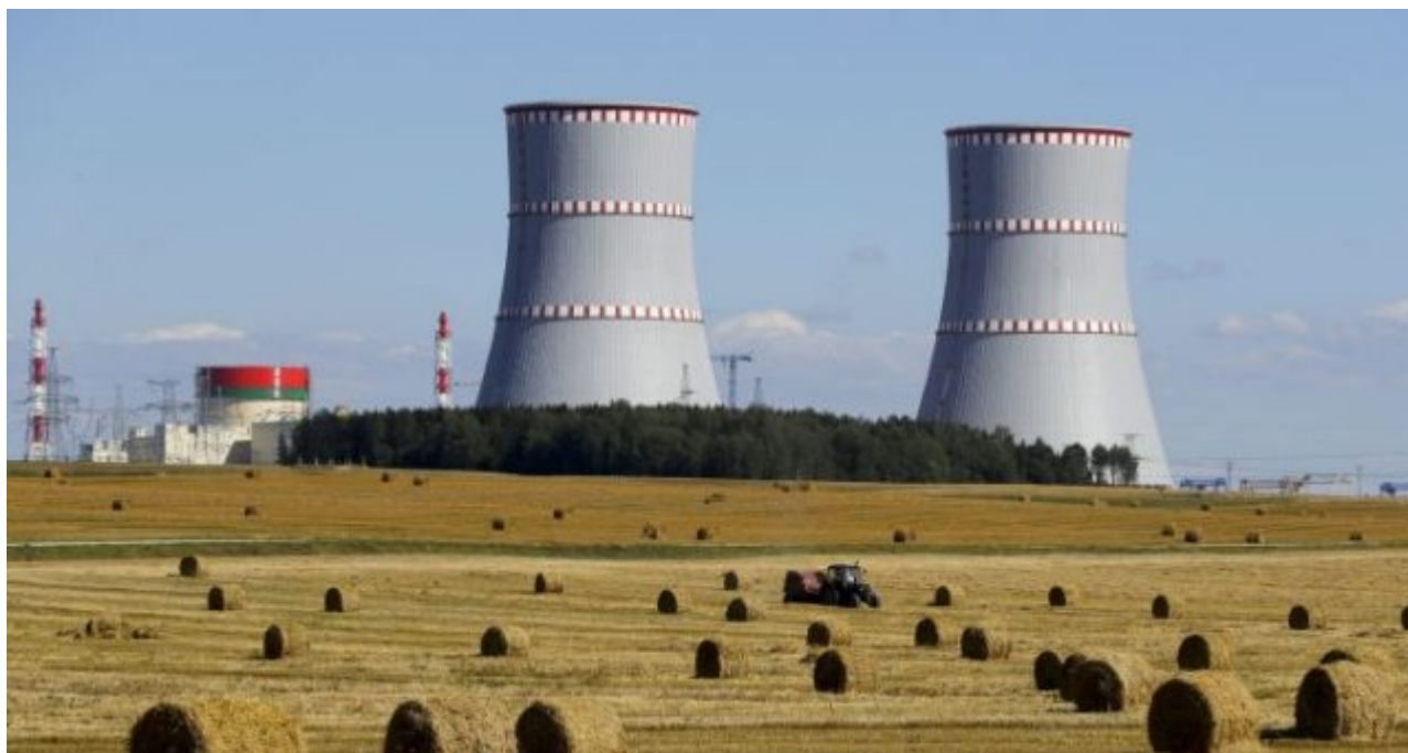
Bieloruská jadrová elektrárňa sa nachádza na severozápadnej hranici Bieloruska
