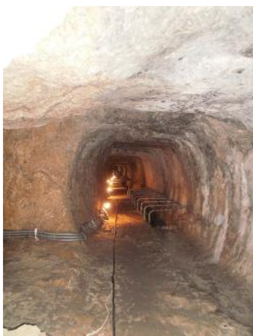
Eupalinův tunel na ostrově Samos. Stavba z let asi 530 až 520 před n. l.
