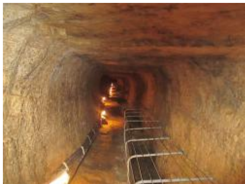
Eupalinův tunel na ostrově Samos.
